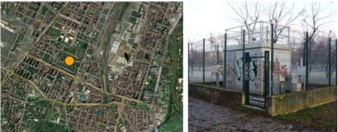
Figura 1 - Stazione di monitoraggio di Torino-Lingotto: posizione della cabina di misura, ortofoto (a sinistra) e foto (a destra)
