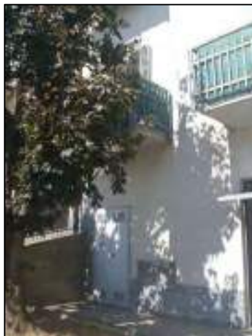
Figura 5 – Cabina elettrica di trasformazione MT/BT in locale sottostante un'abitazione
